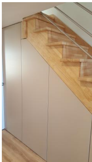
Placard à pan coupé sous un escalier
